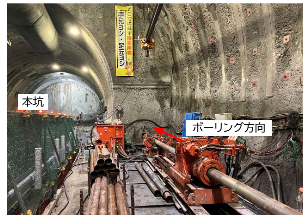
台場山工区ボーリング削孔状況
