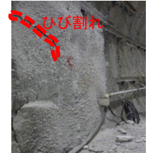
吹付けコンクリートのひび割れ
